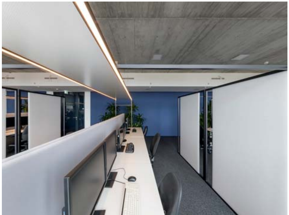
▲ Durchgängige LED-Einsätze in den Profilen über den Schreibtischen dienen als Arbeitsplatzbeleuchtung.
